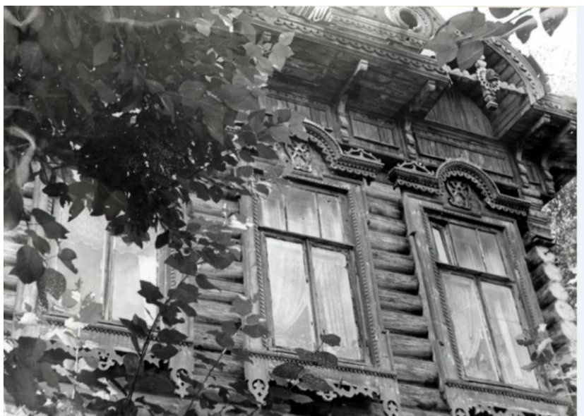
Фото утраченного дома ул. Чкалова, д.13а. Угловая светелка
