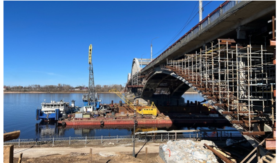
Монтаж специальных вспомогательных сооружений и устройств (СВСиУ) для ремонта моста
